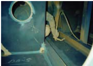
Dikkatli şerit kaplama
