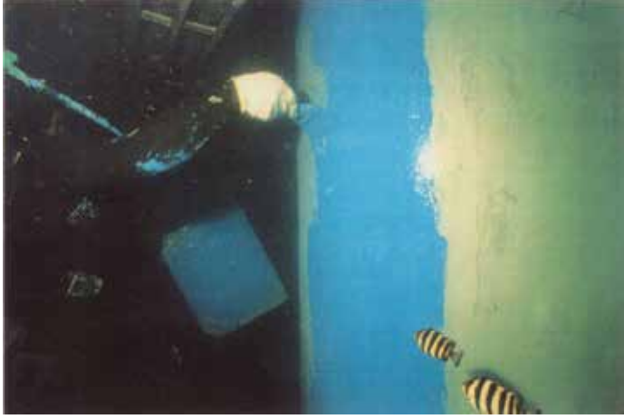
Kauçuk mala ile 600 micron kalınlık
